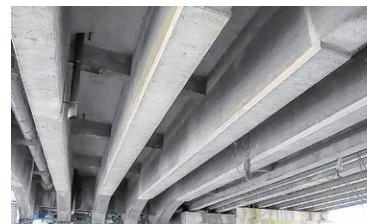
RC主桁の補強
