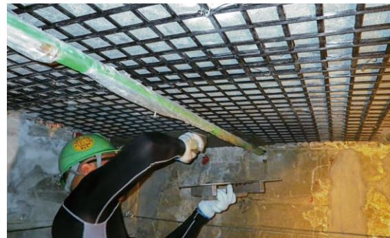
接着系あと施工アンカー(打込みタイプ)
