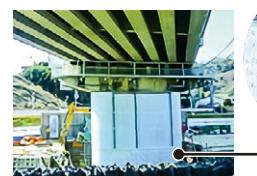
耐震補強・コンクリート巻き立て工
