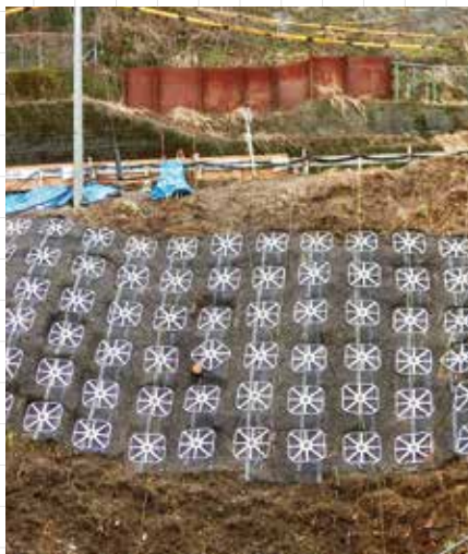
補強土工法の背面
