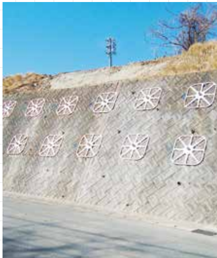
ブロック積擁壁補強
