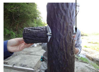
【参考1】 スタート端末取付 端末にボルトをねじ込んでおく
