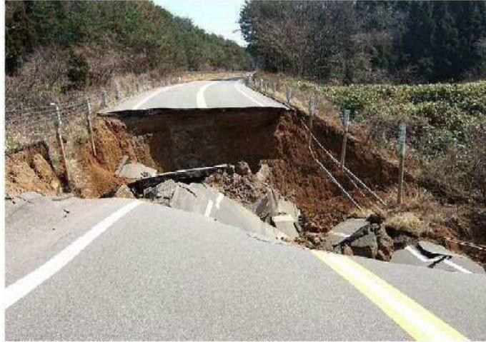
地震による道路盛土の崩壊(道路の寸断)
