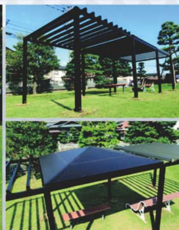
パーゴラ部分(上)/東屋部分(下)
