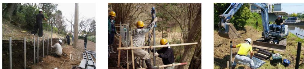
【写真1】鋼管打設例（大ハンマー・杭打機・バックホウ）
