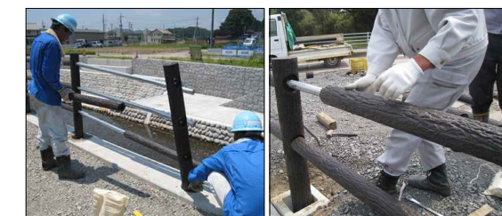
【参考5】芯材(鋼管)に横木樹脂を差し込む 横木樹脂を差し込む
