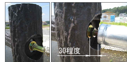
【参考4】芯材(鋼管)を支柱の 中継ぎボルトにねじ込む
