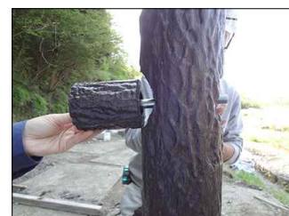
【参考2】スタート端末取付 端末にボルトをねじ込んでおく
