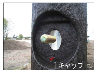
【参考1】横木回転防止用釘 キャップを取る
