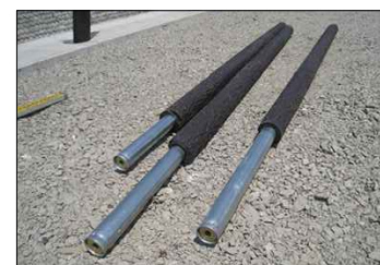
【参考3】芯材抜き取り 内径の大きい側より抜き取る
