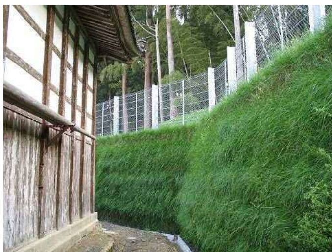
植生により景観に配慮したQKウォール
