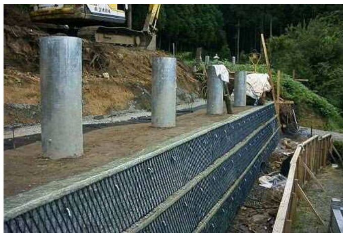
支柱基礎鋼管の立て込み
