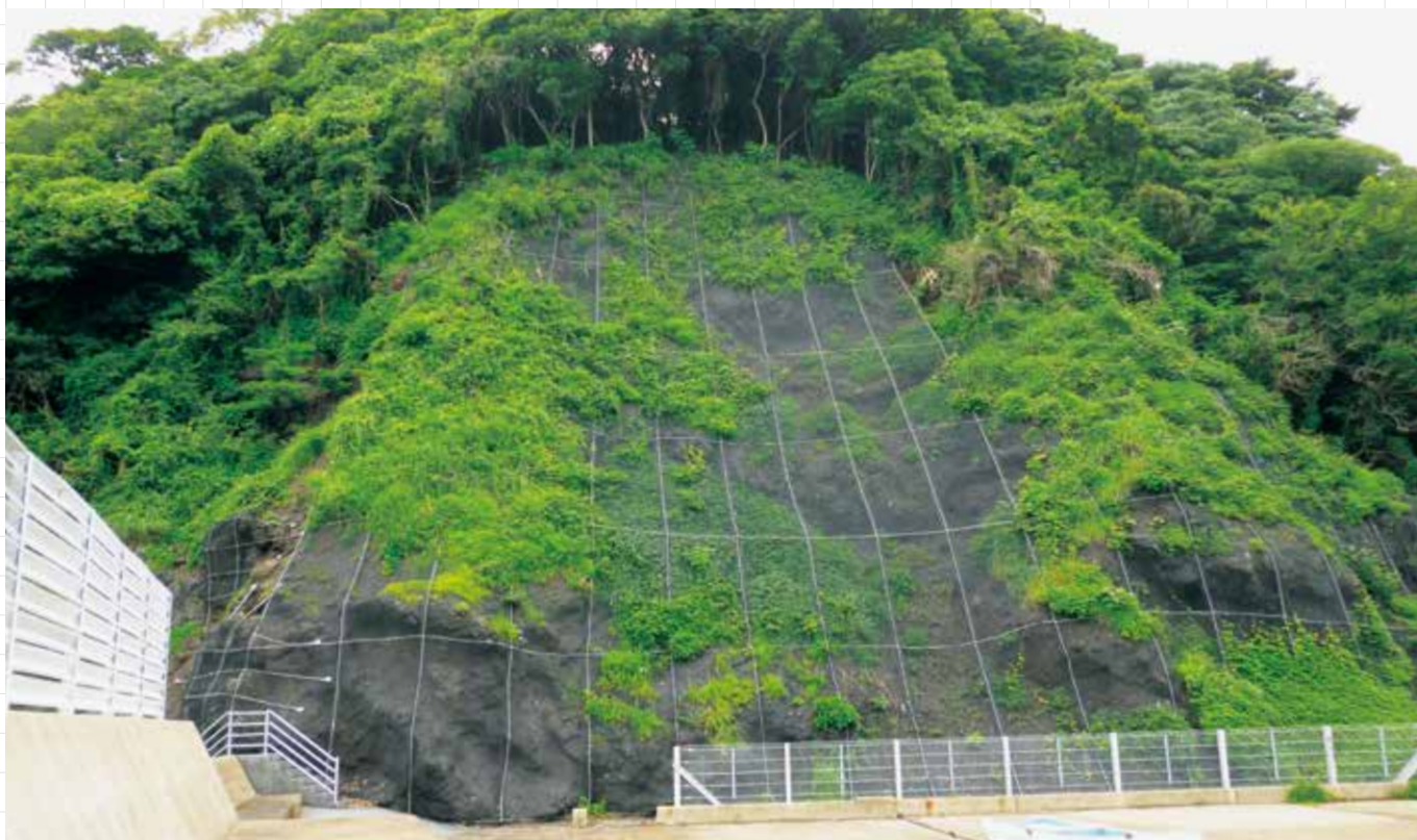
潮風による腐食が懸念される沿岸部の法面に設置
