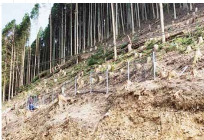
道路横法面の落石対策として設置
