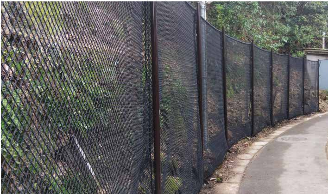
道路横法面の落石対策として設置
