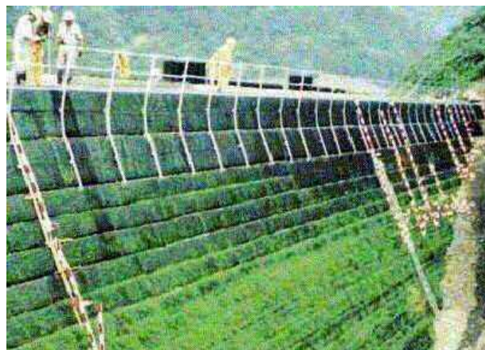
アデムを使用した補強土壁
