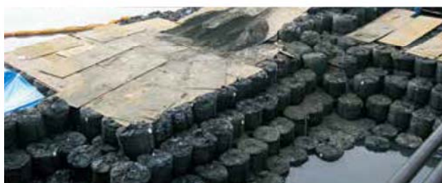
土留工 施工ヤードの土留工として用いた事例
