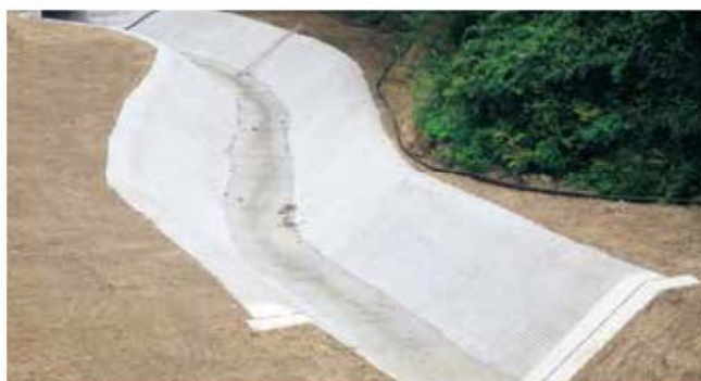
水路工 三面水路の水路工として用いた事例
