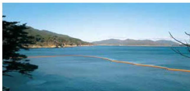
砂浜の再生工事の際に汚水の流出を防いだ事例
