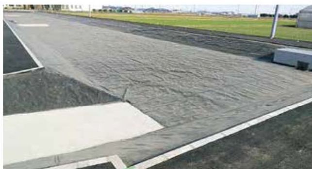
遮水工 調整池の漏水防止として用いた事例
