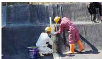
4 重ね合わせ部処理(法面部)
