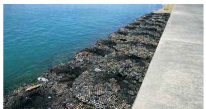
マウンド被覆 防波堤のマウンドの被覆材として用いた事例
