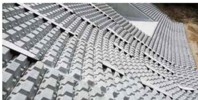
ため池護岸 ため池の護岸に用いた事例(防草防災タイプ)
