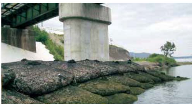
根固工 鉄道の橋脚根固めとして用いた事例
