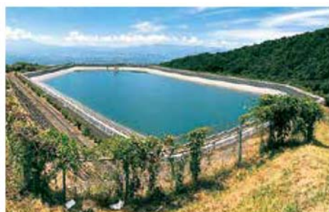
遮水工 ため池工事に長尺広幅シートで敷設した事例
