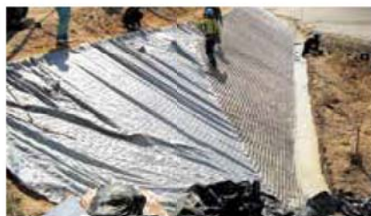
2 モルタル注入
