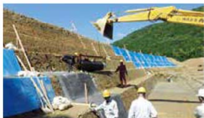
1 シートの敷設
