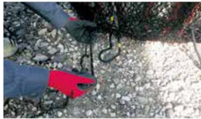
2 網地を型枠に拘束
