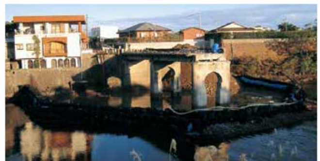
仮締切工 橋脚周りに仮締切として用いた事例
