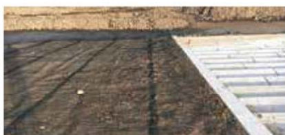
1 メッセルを敷設
