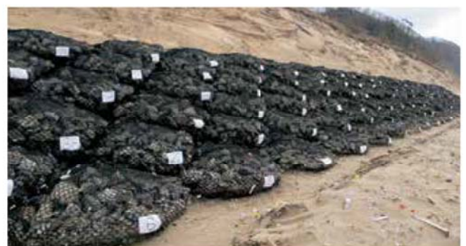
浸食対策 砂浜の海岸浸食対策で用いた事例
