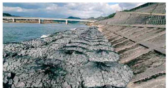
間詰工 護床工の間詰として現地製作・施工した事例
