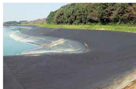
遮水工 ため池改修工事に保護マット上部にシートを敷設した事例
