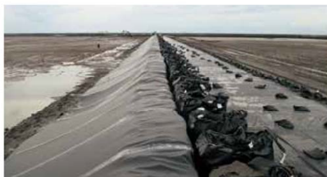
遮水工 デクトシートを土のうに巻き込んで遮水を行った事例
