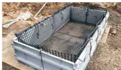
1 型枠に網地を設置
