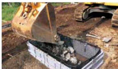
2 中詰材を、拘束ロープ付近まで投入
