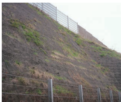
ネット取付完了
