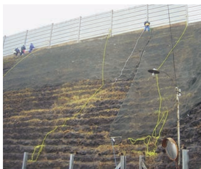
ネット取付状況
