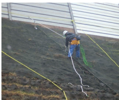
アンカーピン取付状況
